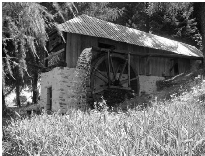
Die Säge in Nax mit dem oberschlächtigen Zellenrad
