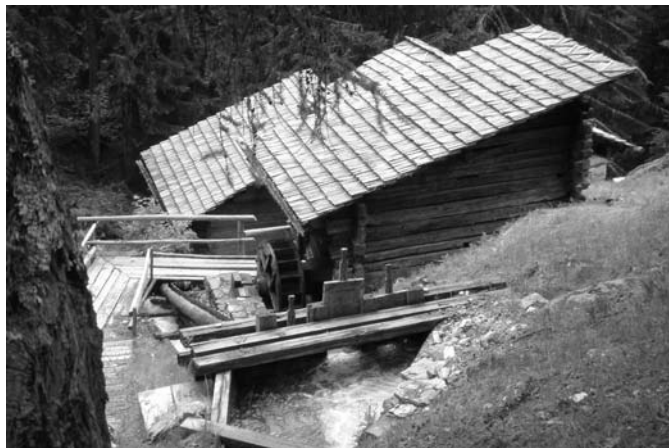
Hier wird das Wasser auf die Roggenmühle und die Stoffwalke verteilt. In der Mitte: Wasserablass
