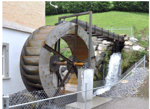
Abb. 3: Wasserrad ehemalige Getreidemühle Alt St. Johann.
