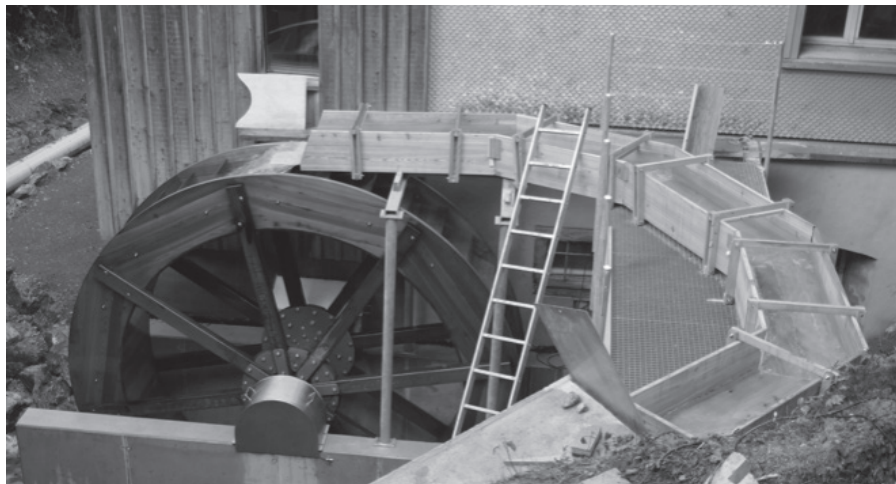
Neues Wasserrad am Hagtobelbach in Wattwil, Anlage Nr. 52
