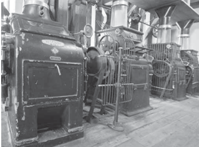
Abb. 13 Walzenstühle der italienischen Firma Società Anonima Meccanica Lombarda di Monza aus dem Jahre 1890
