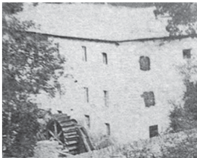
Abb. 6 Detail der Mühle von Westen, mit unterschlächtigem Wasserrad um 1870
