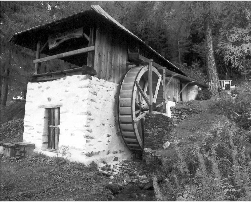
Abb. 1. Anordnung des Sägegebäudes quer zum Hang ergibt einen hohen Gatterkeller (Nax VS).
