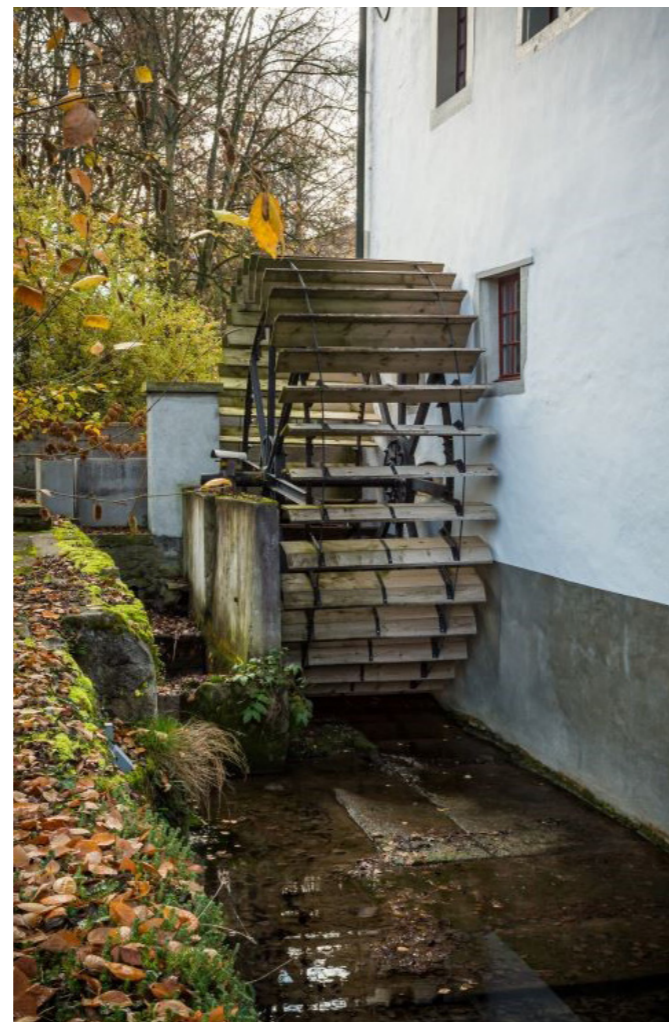
Abb. 2: Das unterschlächtige Wasserrad mit den abgewinkelten Schaukeln (D 4.45 x B 1.90 m) stand seit 1963 still. Es wurde durch Kurt Fasnacht restauriert (© Mühlerama-Seon AG, Seon).
