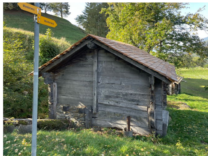
Abb. 1: Mühle Bonacher Ernen mit renoviertem und neu eingedecktem Schindeldach Herbst 2023
