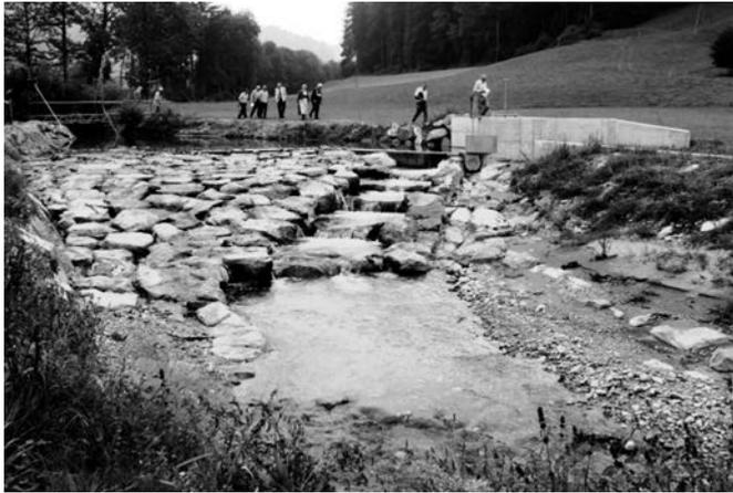
Abb. 6 Streichwehr der Reppisch 7.15 m breit, Krone 579.88 m ü.M. (obere Gefällsgrenze bei mittlerem Wasserspiegel). Der Unterbau ist gemauert, der obere Teil bestand aus einem Eichenbrett. Das Streichwehr leitet das Wasser der Reppisch in den Mühlekanal. Eine Mindest-Restwassermenge von ca. 10 l/sec blieb in der Reppisch.
