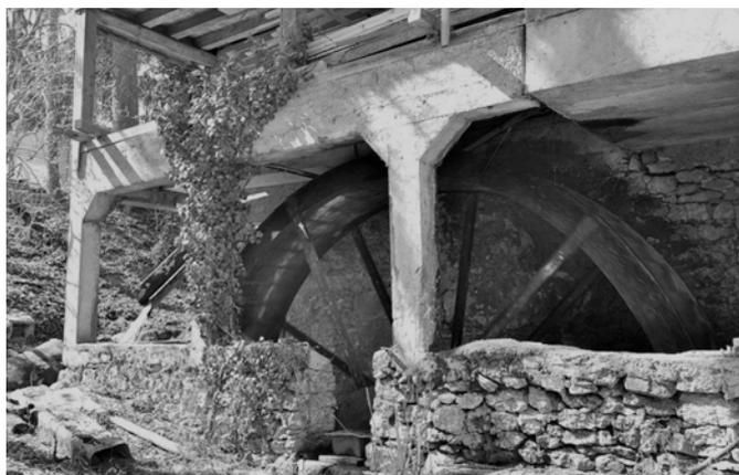
Abb. 10 Das untere Wasserrad der Scierie de Moiry. Dieses dient zum Antrieb der Säge und als Stromlieferant. Quelle: Olivier Crisinel
