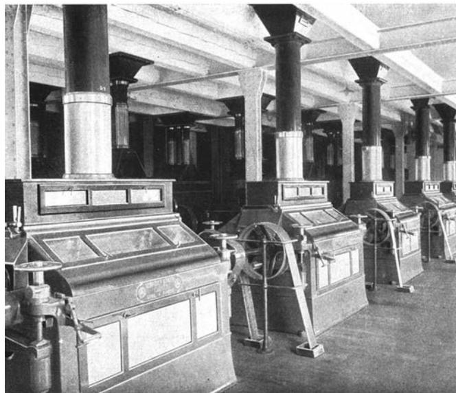
Abb. 13 Die neuen Bühler Walzenstühle im Parterre des Neubaus. Quelle: Ein Mühlenneubau des Architekten Johann Bucher in Luzern.<sup>9</sup>
