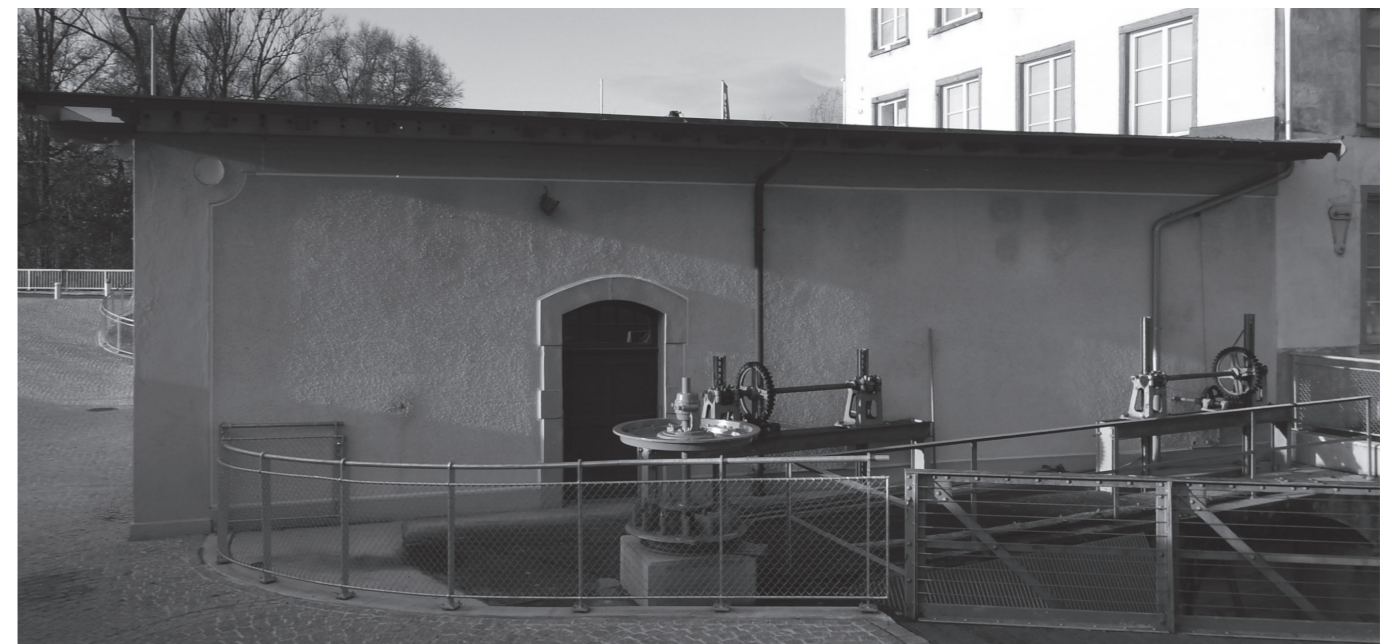
Abb. 2: Turbinengebäude mit Einlauf- und Leerlaufbauwerk. Die ehemalige Turbine der Lochmühle Huttwil dient als Stele und Demoobjekt
